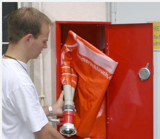
Torabdichtung im Wandbehälter
